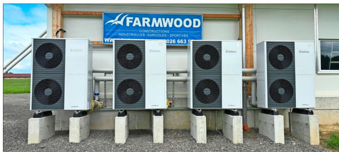
Insgesamt vier Wärmepumpen des deutschen Familienunternehmens Vaillant sind an der Aussenwand der Masthalle montiert. Je nach Wärmebedarf laufen mehr oder weniger Pumpen.
